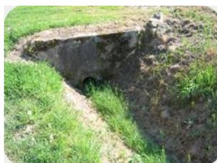
**La rue Verte (face au n°53)**, où l'ouvrage bétonné sera détruit. Une grille et un tuyau qui traversera la route vont être installés.
